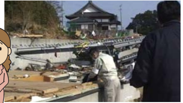
損害調査の様子
